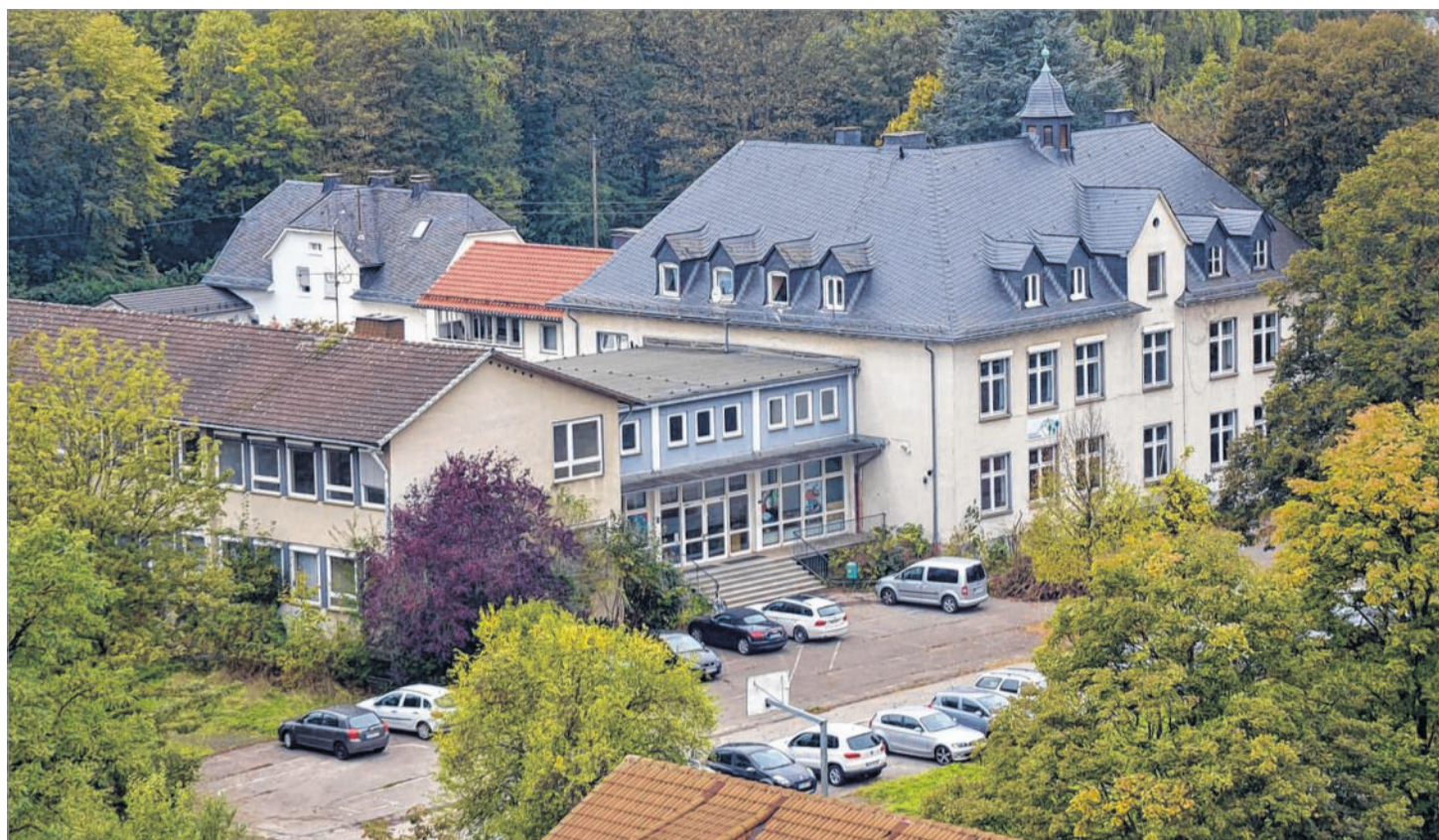
Dieses Foto der 2008 aufgelösten Deichwaldschule in Buschhütten hat bald historischen Wert: Der Abriss steht offenbar kurz bevor. Dort soll ein neues Wohnquartier entstehen mit integrierten vollstationären Pflegeeinheiten, ambulant-betreutem Wohnen und barrierefreien Wohnungen. Archivfoto: bjö
