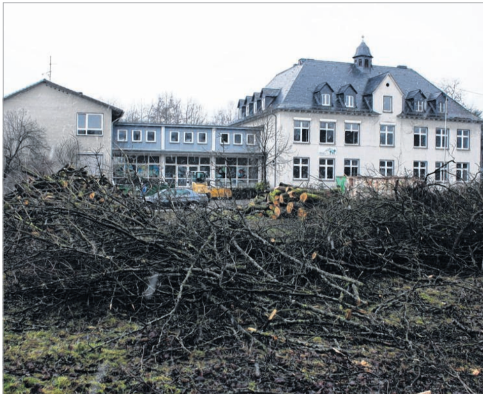
Der Abriss des Gebäudes, aus dem die Hauptschule 2009 „auszog“ – Anlass war bekanntlich ihre Auflösung – steht noch bevor. Die Bäume im Bereich des früheren Pausenhofs mussten derweil schon weichen.
