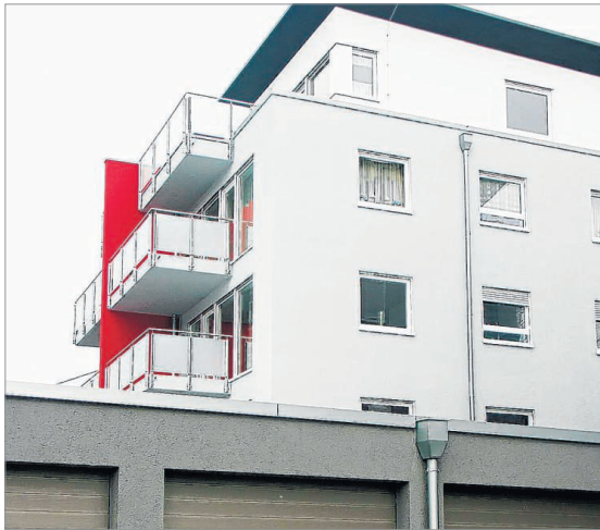
Innerhalb eines Jahres wurden jetzt die drei neuen Stadthäuser Im Wiesental 46 A, 48 bis 50 installiert.
