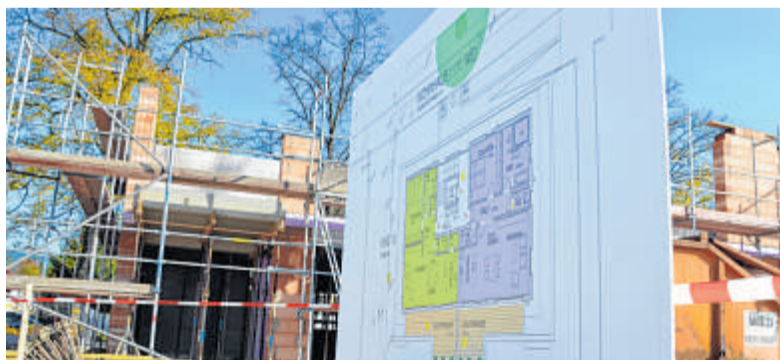
Am Heugraben in Kreuztal wird eifrig gebaut: Noch befinden sich die vier Häuser, die an der Siegener Straße entstehen, allerdings im Rohbau. FOTO: FLEMMING KRAUSE
